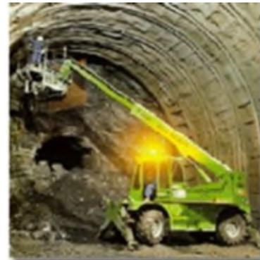
Arbeitsplattform, die mit einem Teleskopstapler zusammengebaut ist
